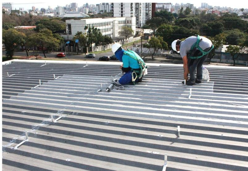
Instalação da estrutura para as placas fotovoltaicas
