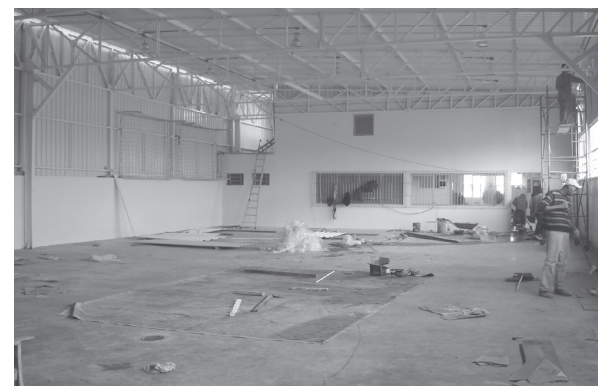
Salão de Multiuso em fase final de construção
